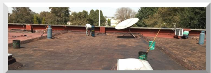
Fotos 4.7 y 4.8 Azotea de edificio K y M (antes)
