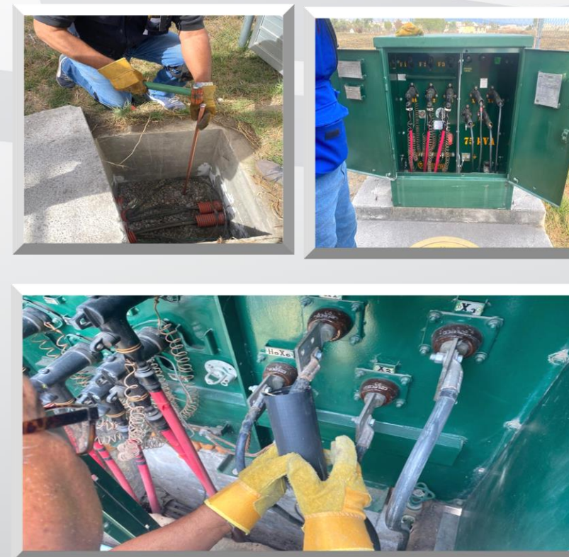
Fotos 4.20, 4.21 y 4.22 Mantenimiento a transformadores eléctricos
