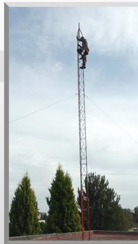
Fotos 4.5 y 4.6 Mantenimiento a pararrayos
